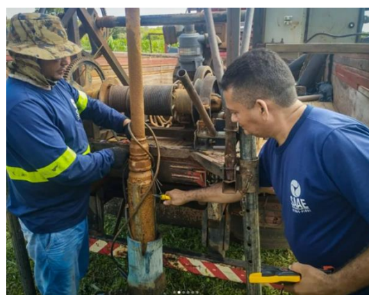
Equipe executando o serviço de troca de conjunto motor-bomba submersa
