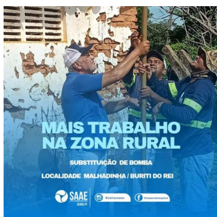
Equipe executando o serviço de troca de conjunto motor-bomba submersa.
