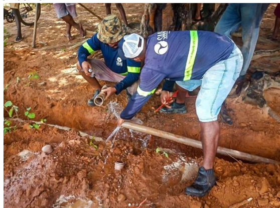
Equipe trabalhando na extensão da rede de abastecimento de água
