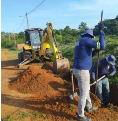
Expansão da rede de abastecimento de água
