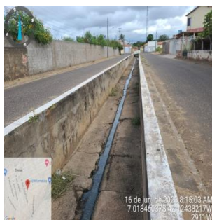
Limpeza de galeria
