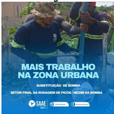
Equipe executando o serviço de troca de conjunto motor-bomba submersa na zona urbana
